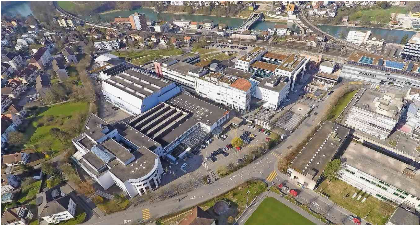
So präsentiert sich die Situation heute: Auf der Fläche des Freizeitlands mit dem Baumarkt Migros Do it + Garden und dem Aussenparkplatz davor soll der neue Sälipark entstehen (siehe Darstellung unten). Die Turnhallen Giroud Olma hinter dem Freizeitland bleiben bestehen.
